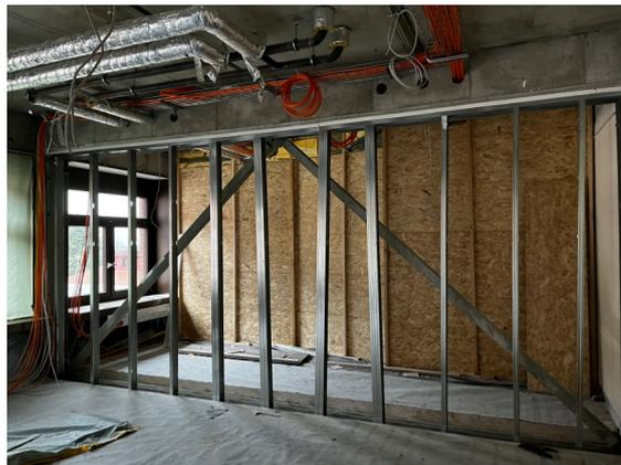
*Entfernte Betonwand (links) und neuer Trockenbau (rechts).*
